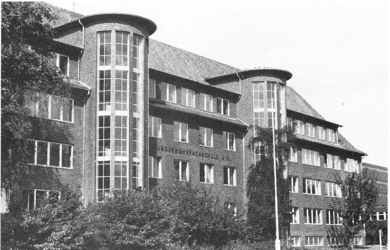
Abb. 29 Hauptfassade der Bundeswehrfachschule an der Herthastrafße (ehem. Marinefachschule, erb. 1935 Marine-Standortbauamt Kiel).
