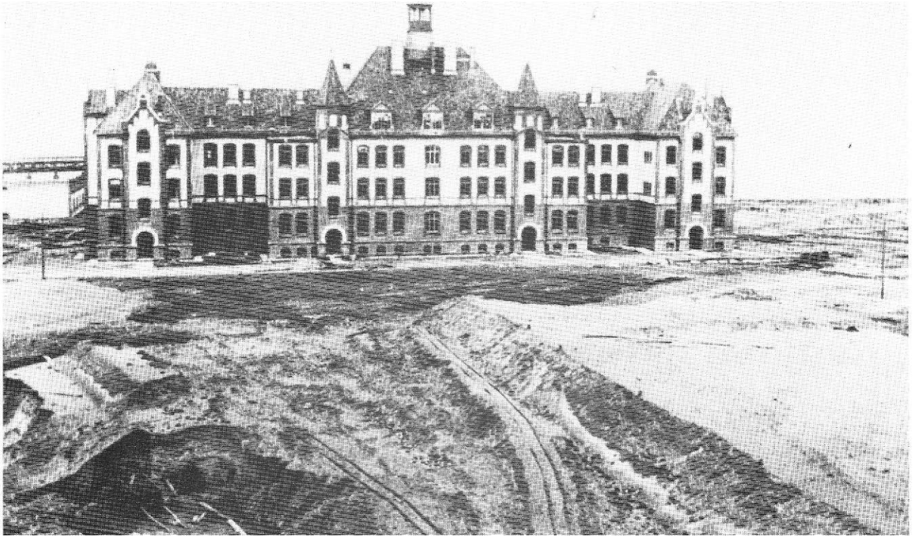
Abb. 21 Alte Ansicht der Marine-Kasernen für die 1. Werftdivision in Kiel-Wik: Fassaden heute stark vereinfacht.
