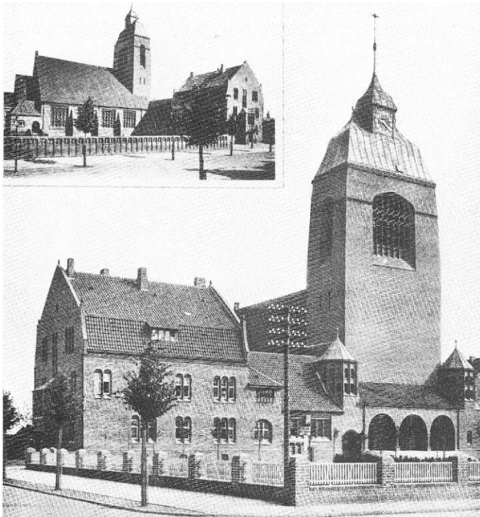
Abb. 2 Altaufnahme der Wiker Petruskirche (kurz nach der Erbauung, 1905-07/09 v. Curjel u. Moser), der ehem. Marine-Garrisonkirche, gesehen aus der Adalbertstraße/Ecke Weimarer Straße; oben Ansicht der Westseite mit gegliederter Friedhofsmauer und Pastoratsgebäude. Die TMS noch nicht sichtbar.
