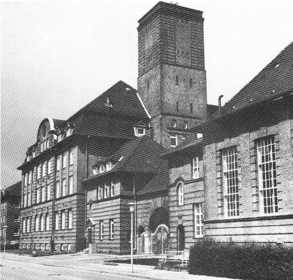
Abb. 1a Heutige Ansicht der Technischen Marineschule in der Wik (Aufn. 1988), der Turm seit 1936/37 um ein rustiziertes Geschöß erhöht, die Dachdeckung verändert; sehr gut die Erneuerung der gesproßten „Industriefenster“ am Maschinensaalgebäude (rechts), die wohl in das moderat repräsentative Gesamtkonzept der Fassaden einstimmen und das Technisch-Funktionelle des eigentlichen Bauzwecks nicht verleugnen; auffällig die sehr hoch gezogene Sturzmauerung über diesen Fenstern.
