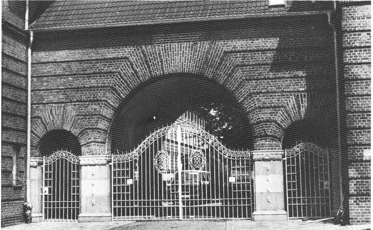
Abb. 5 Blick aus der Arkonastraße durch das schöne, noch leicht jugendstilige Ziergitter der ehem. Hauptdurchfahrt in den Hof der TMS, im Hintergrund der Erweiterungsbau von 1936, die leicht rötlichen Granitpfeiler sehr schön gereinigt und restauriert, die Torgewölbe angemessen hell gestrichen, die gewölbeteilenden Gurtbögen mit farblich grundierten, jugendstilisierten Ornamentfeldern.
