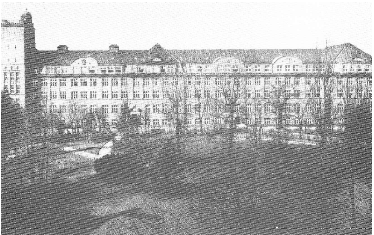
Abb. 25 Hofansicht des 1936stark erweiterten Schulgebäudes der TMS, Turm noch nicht erhöht; der wiederholte Pavillontrakt (rechts außen im Krieg zerstört und jüngst durch schmalen Treppenhausflügel ersetzt (s. Abb. 26); Entwurf der Erweiterungsbauten 1935 von Baurat Sembecher, Ausführung 1936/37.
